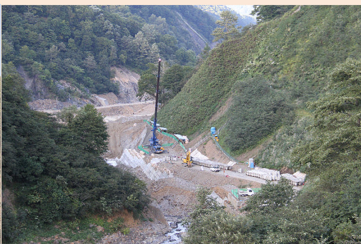
国土交通省で実施されている金山沢の砂防堰堤工事
