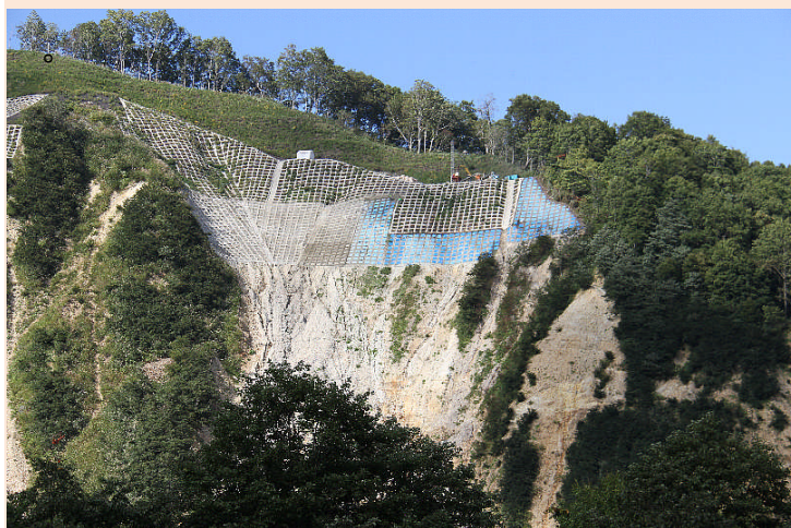
林野庁で実施されている唐松沢の溪岸崩壊対策の治山工事
