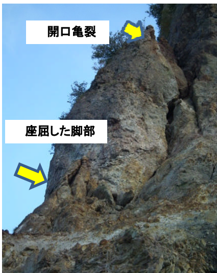
(図2: 座屈変形した不安定な岩塊) (地獄谷右岸側)
