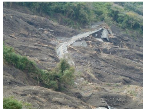
御神火スカイライン(中腹部)の様子
